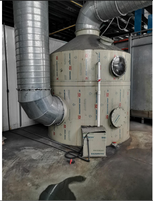
1#喷涂、烘干生产的废气、超声波清洗废气、砂纸打磨废气处理措施(DA001)
