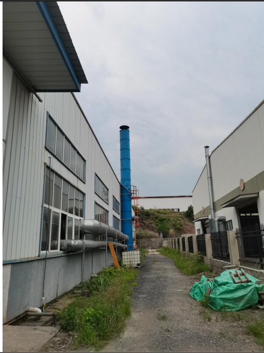
1#喷涂、烘干生产的废气、超声波清洗废气、砂纸打磨废气处理措施(DA001)
